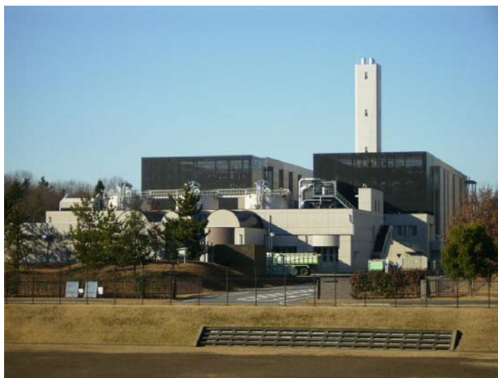
栃木県下水道資源化工場
