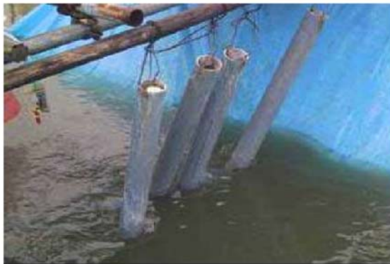
処理施設故障時の対応例 仮設沈殿池への固形塩素供給
