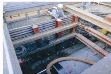
雨水管理設工事
