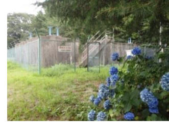
穴沢第 1 配水池
