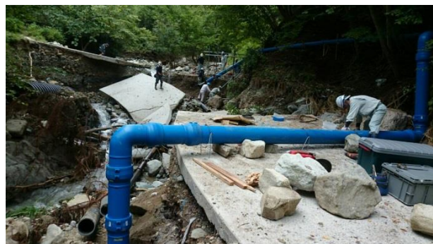
(復旧工事の様子)
