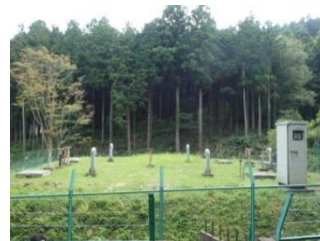
金沢下配水池
