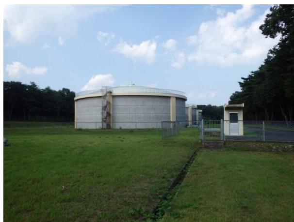
図 3.9 北那須水道折戸調整池
