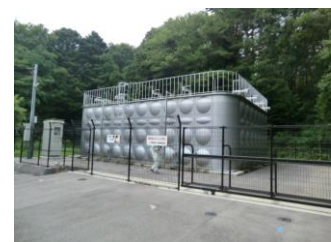
板室本村低区配水池
