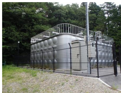
(板室本村低区配水池)
