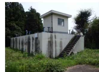
高林第 2 配水池
