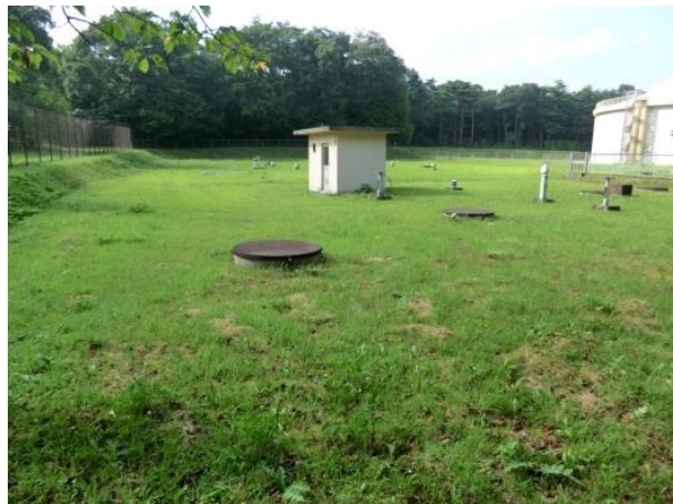
図 3.8 北那須配水池
