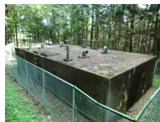
宇都野配水池
