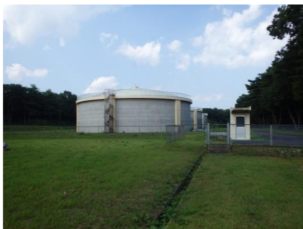
(県営北那須水道受水池)
