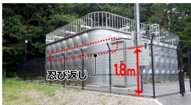
図 5.2 適正な外周フェンス（板室本村低区配水池）
