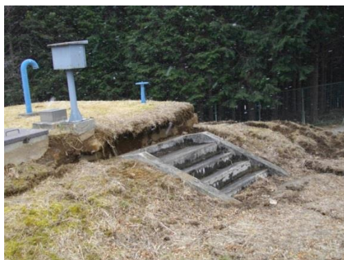
(熊久保配水池)
