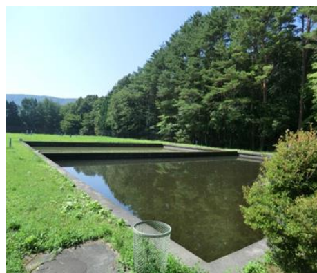
要害浄水場 緩速ろ過池
