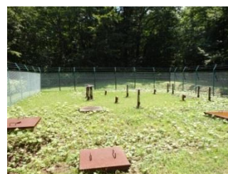
新湯第 2 配水池
