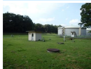
北那須配水池
