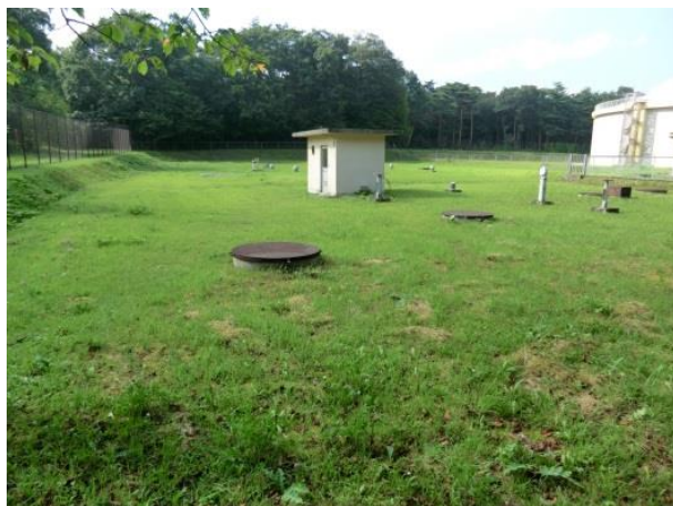
(北那須配水池)
