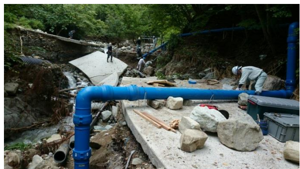
(復旧工事の様子)
