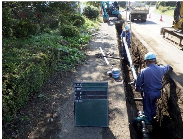
図 5.8 耐震管路布設工事の様子
