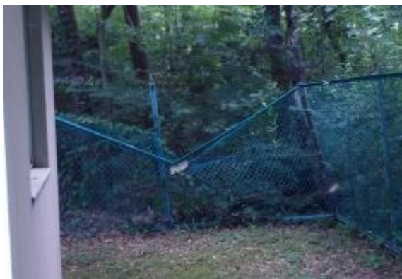
(青木第2配水池)
