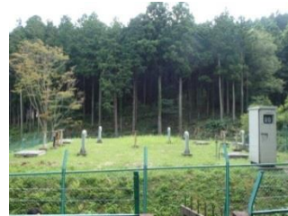
金沢下配水池
