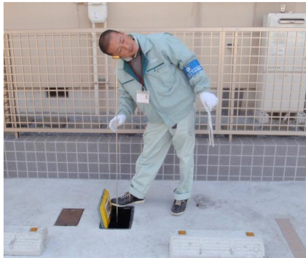
漏水調査の実施状況
