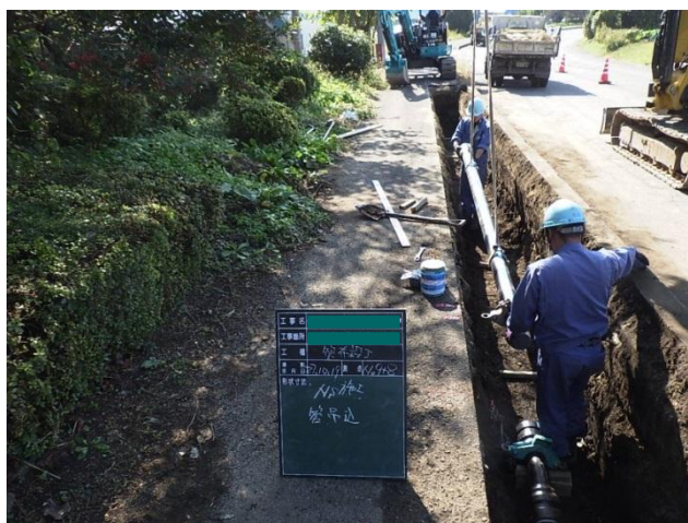
図 2.5 耐震管路布設工事の様子
