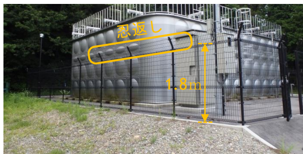
図 2.1 適正な外周フェンス（板室本村低区配水池）
