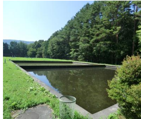
要害浄水場 緩速ろ過池 注4
