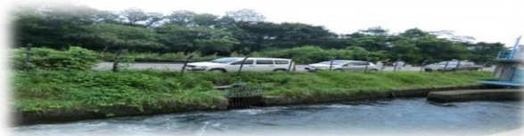
鳥野目浄水場への取水口
