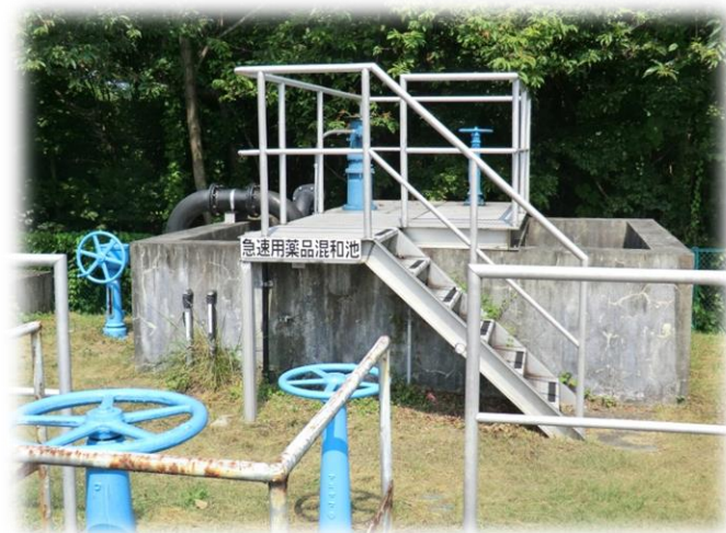
薬品混和池（鳥野目浄水場）
