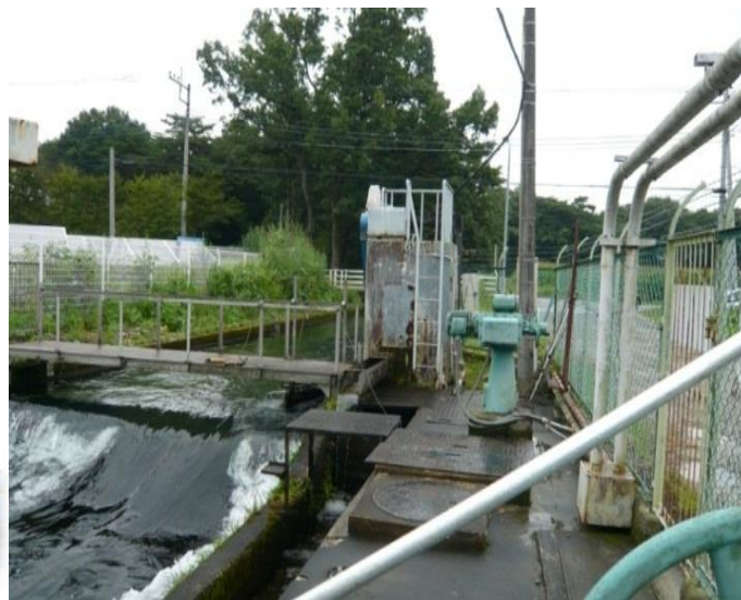
千本松浄水場への取水口 (取水口は那須疏水にあります)
