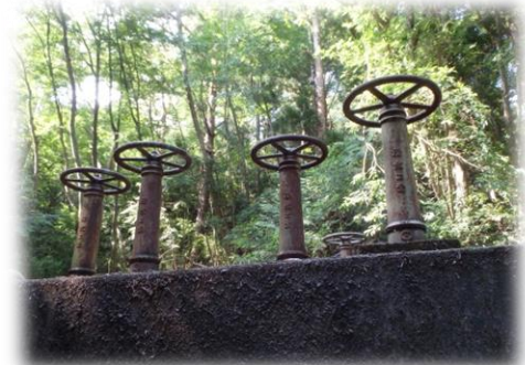
老朽化した宇都野配水池
