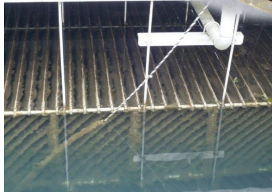
沈澱池内傾斜板
