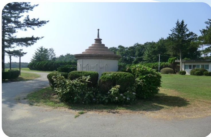
配水塔（鳥野目浄水場 昭和9年築造）
