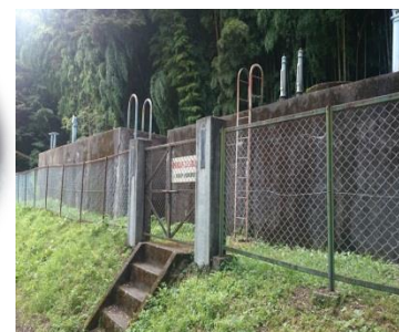
老朽化した施設 昭和43年築造 （関谷配水池）
