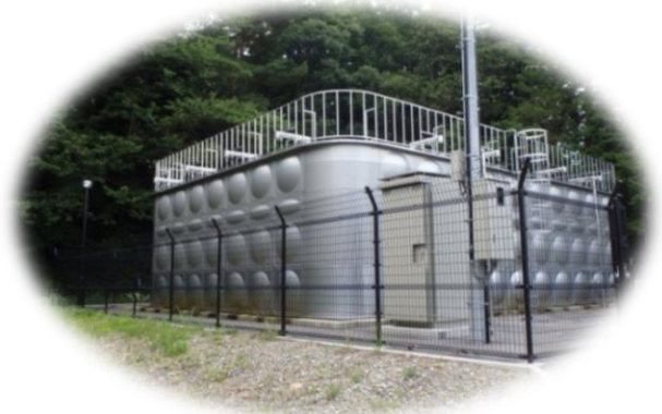
板室低区配水池（平成25年築造）
