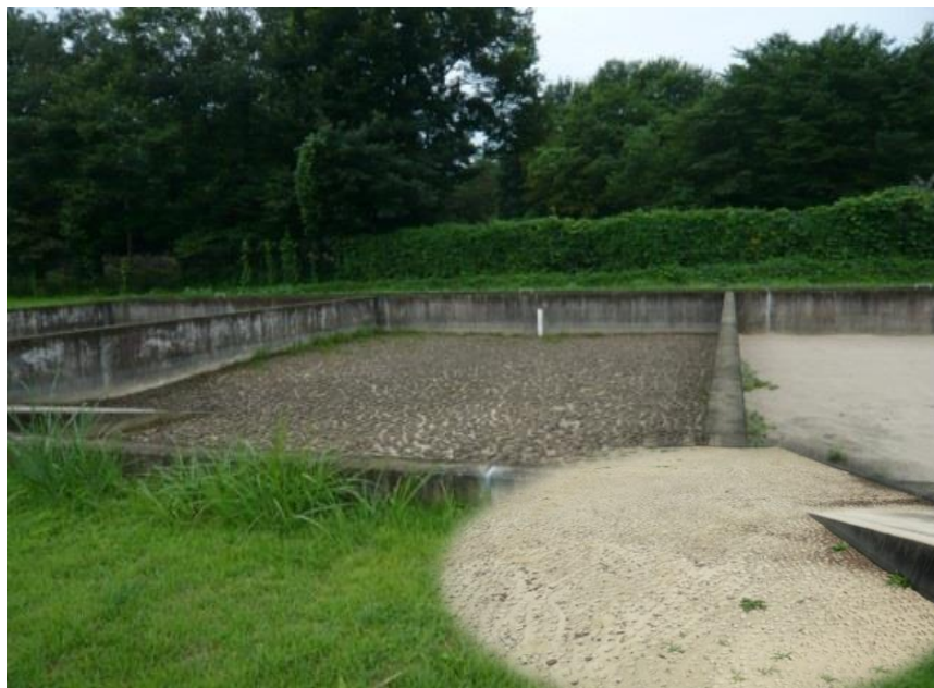
天日乾燥床 (千本松浄水場)
