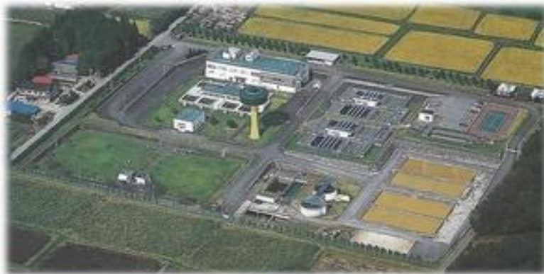
北那須水道事務所（県HPより）
