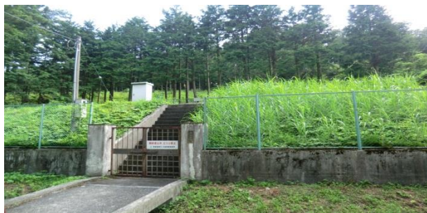
木の俣配水池（昭和62年築造）
