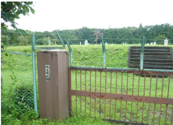
西那須野低区配水池
