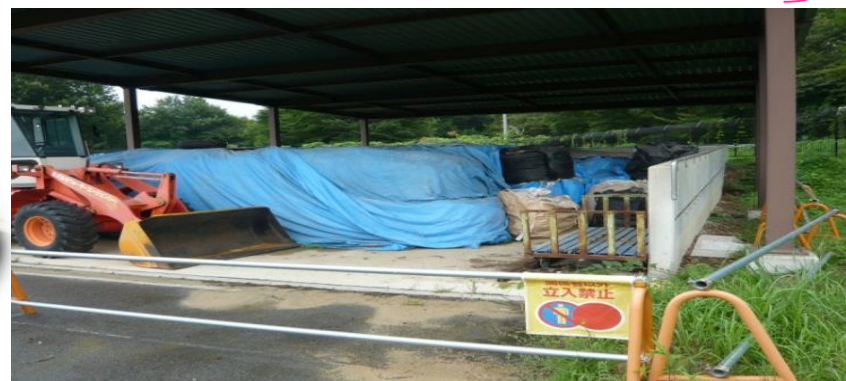
乾燥泥ストックヤード (千本松浄水場)
