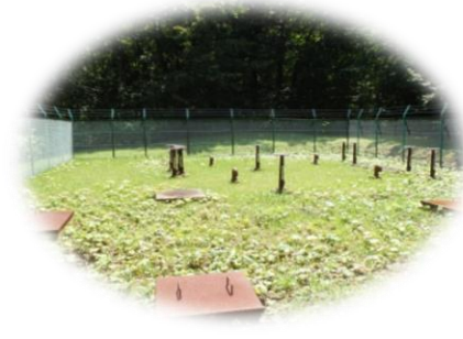
新湯配水池（平成2年築造）
