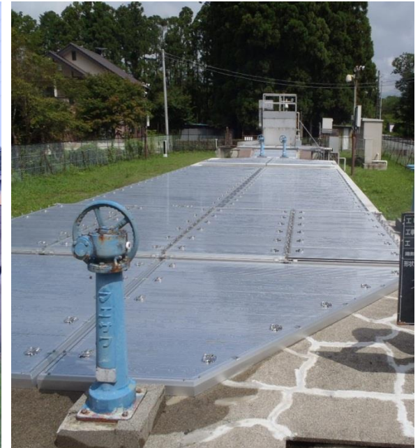
高管理の安全な施設（平成27） 取水口への覆蓋（鳥野目浄水場）
