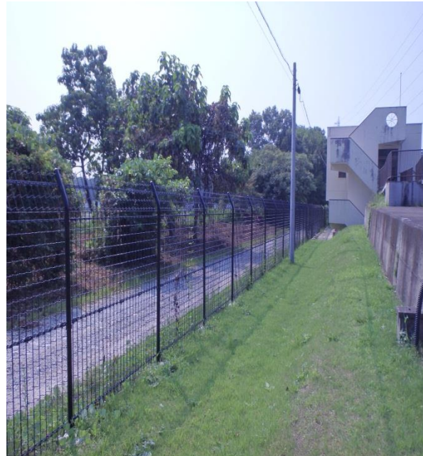
高管理の安全な施設（平成25） 防護柵の改良（千本松浄水場）
