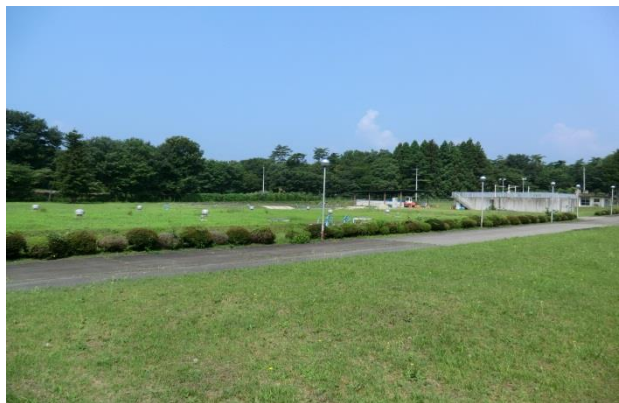
千本松浄水場内配水池
