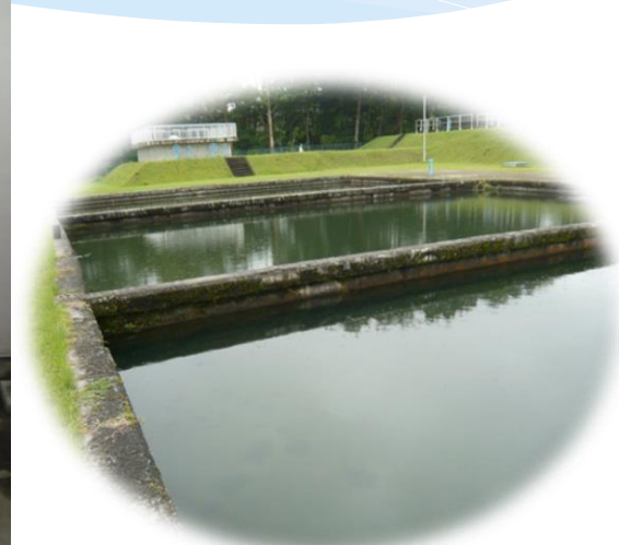
砂の層を利用し、ゆっくりろ過します (緩速ろ過 鳥野目浄水場)
