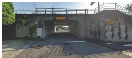
写真 1-4 橋本町横線カルバートの設置状況
