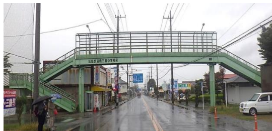
写真 1-4 三島歩道橋の設置状況
