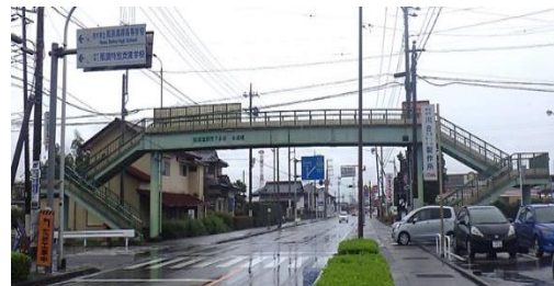
写真 1-5 下永田歩道橋の設置状況
