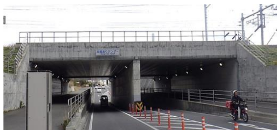
写真 1-2 本郷通りカルバートの設置状況
