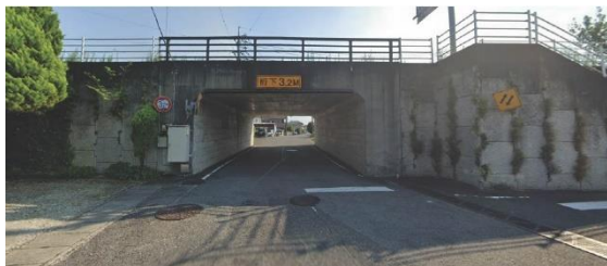
写真 1-4 橋本町横線カルバートの設置状況
