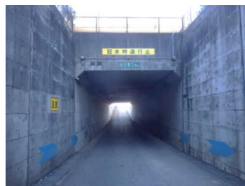
写真 1-3 大門先カルバートの設置状況
