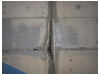
写真 1-8 損傷の状況
