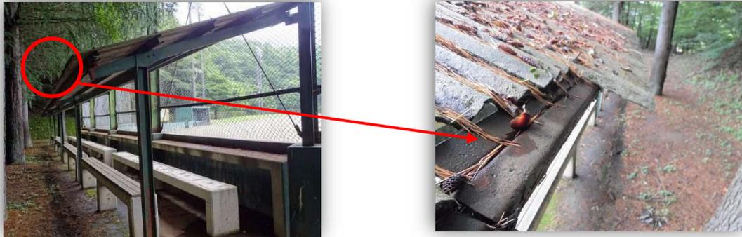
写真3：塩原運動公園 観客席 「D判定」（屋根スレートの破損）
