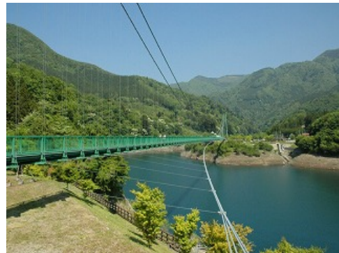
もみじ谷大吊橋
