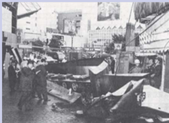
台風で落下した時の様子
