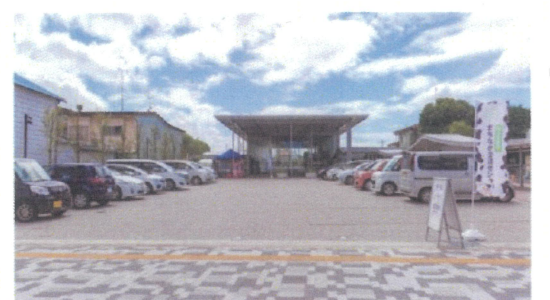
駐車場 (施設正面) 面積 740㎡
