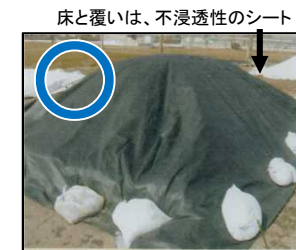
不浸透性シートによる簡易対応
