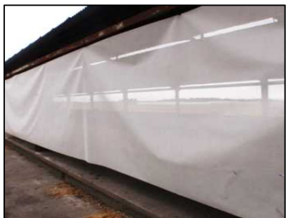
開放型堆肥化施設に消臭シート設置
