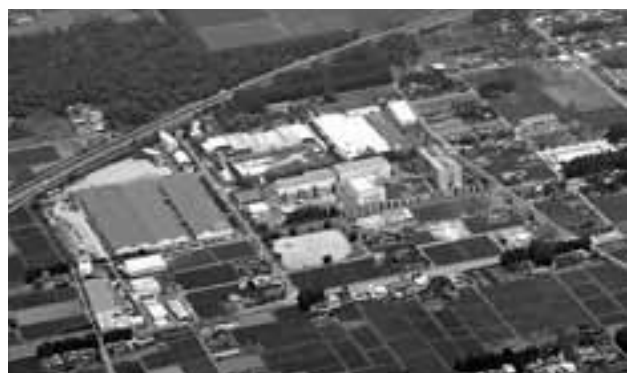
市内に立地する工業団地
