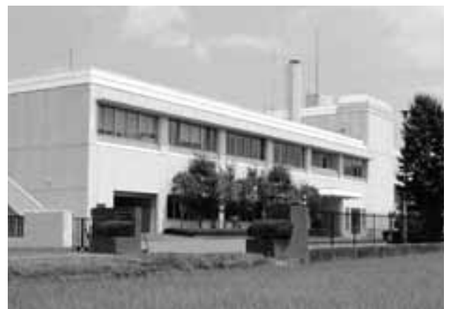
黒磯水処理センター
