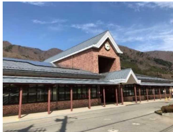
市役所塩原庁舎の太陽光発電
