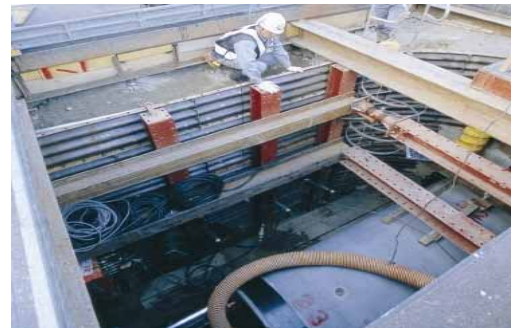
雨水管理設工事
