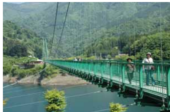
もみじ谷大吊橋
