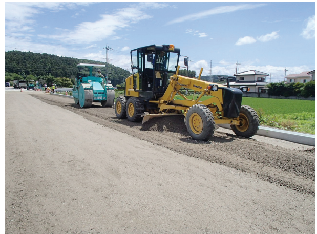
修繕中の道路
