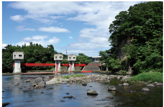
那珂川（西岩崎頭首工）
