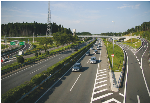
黒磯板室インターチェンジ
