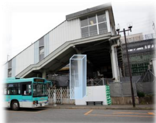
那須塩原市東口エレベータ （※令和元年度完成予定）
