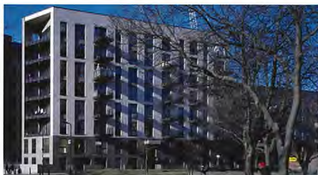
Bridport house(イギリス ロンドン) 8階建て(1階~8階までCLT構造) 写真: http://www.bdonline.co.uk/
