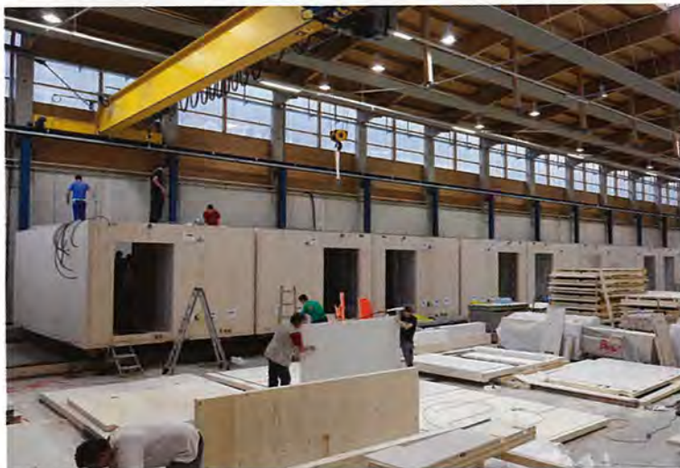
工場でプレファブ化し、配線や内装工事を済ませて現場に搬入
