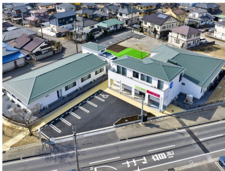
[(医)湘風会 看護小規模多機能型居宅介護施設 もくれん 2023年4月開所]
