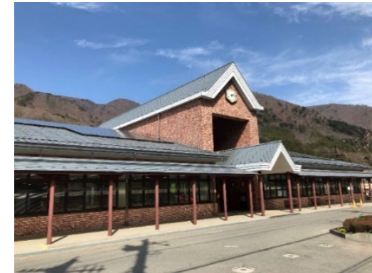
図2-9 市役所塩原庁舎の太陽光発電
