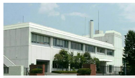
下水処理場脱水汚泥
