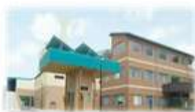
那須塩原クリーンセンター
