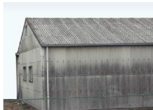
石綿含有スレート波板（屋根・外壁）
