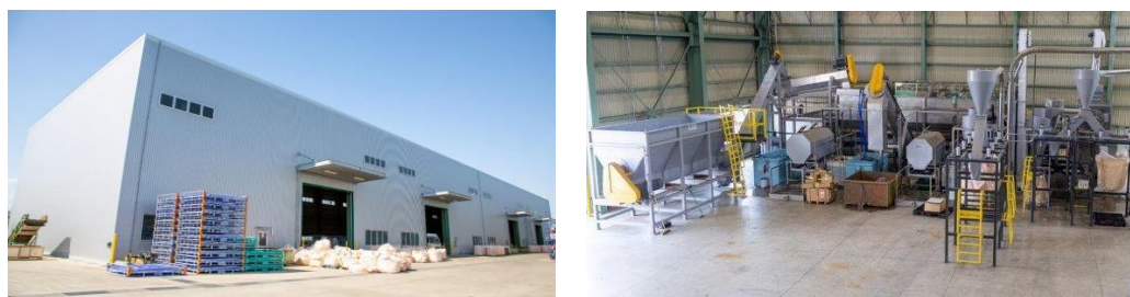
図 1.2.2.1 リバー株式会社 那須事業所 新設した硬質プラスチックの選別ライン
