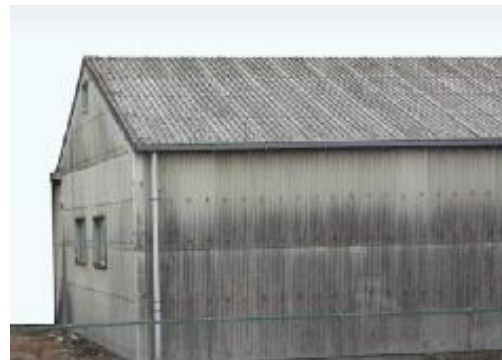
石綿含有スレート波板（屋根・外壁）
