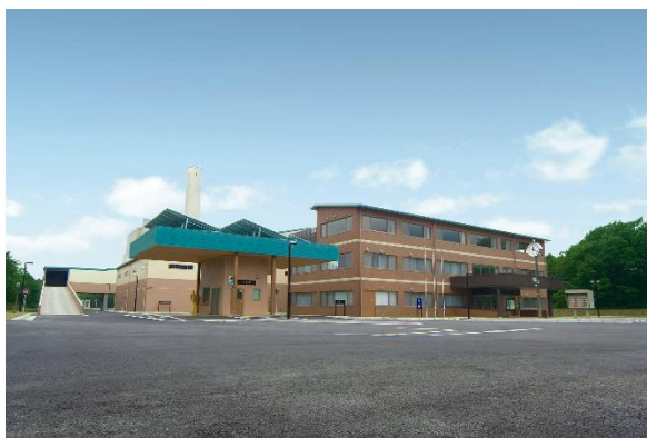
那須塩原クリーンセンター
