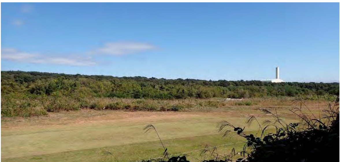
⑧蛇尾川右岸からの事業区域の状況
