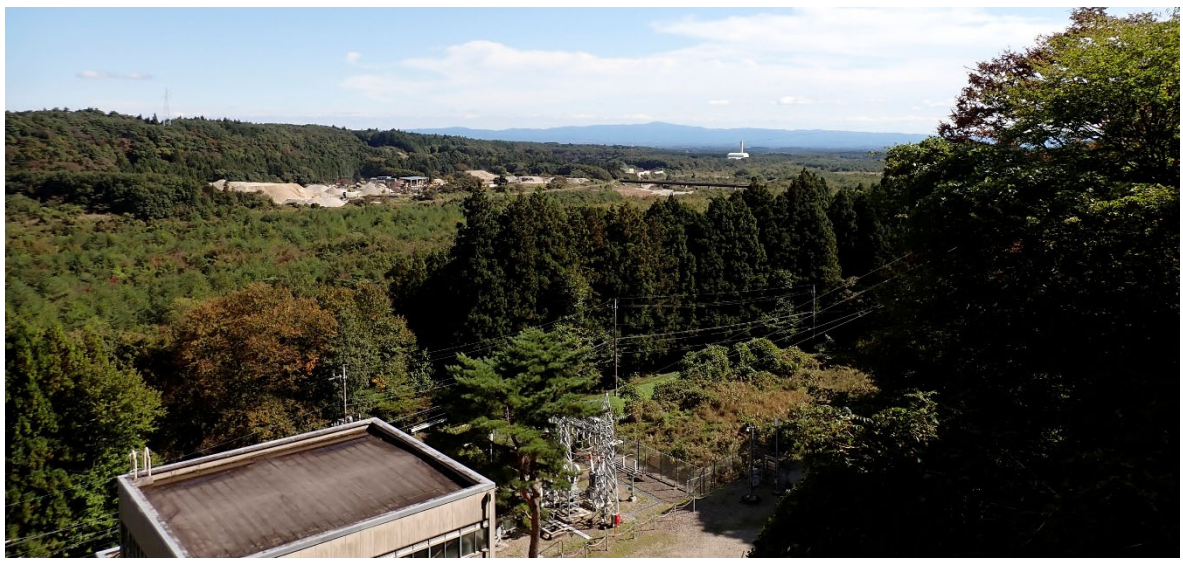
①東京電力リニューアブルパワー(株)蛇尾川発電所付近からの事業区域の状況
