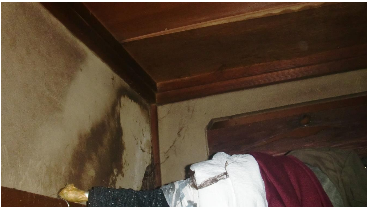
⑬ 1階和室天井
