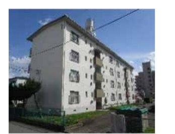
▲市営住宅錦団地
