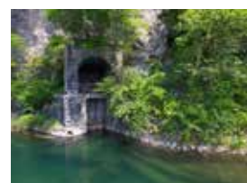
那須疎水取水口
