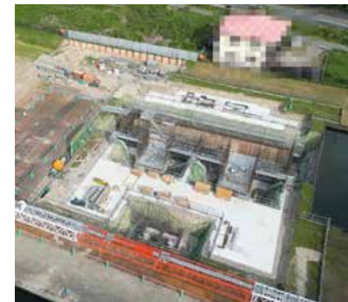
▲鳥野目浄水場 躯体の内部施工の様子
