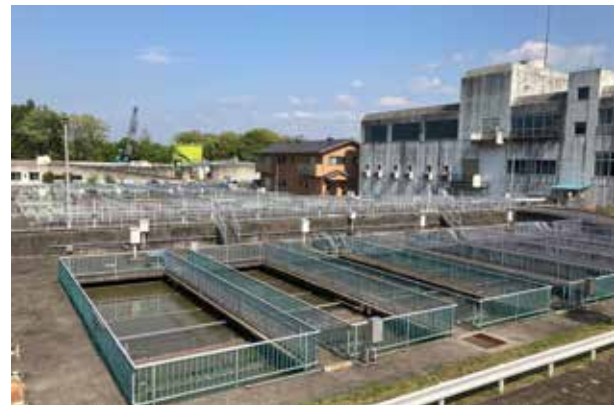
▲黒磯水処理センター
