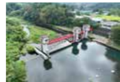
那須疎水取水口
