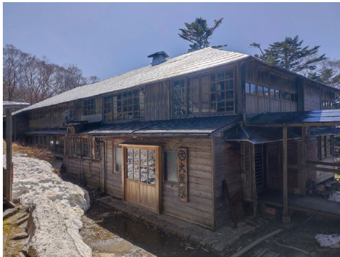
三斗小屋温泉大黒屋旅館本館
