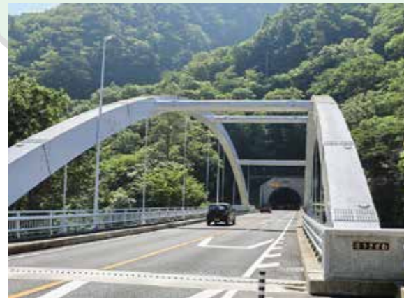
5 令和4(2022)年3月 下塩原バイパス潜竜峡トンネル開通 崖が多い道路を避けて塩原地区への往来が可能に
