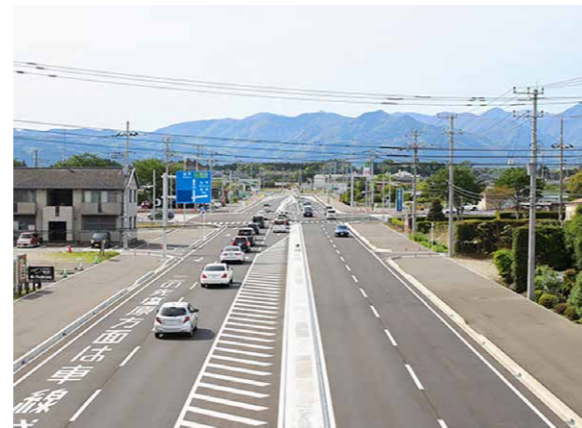
2 道路拡幅工事が進む西三島地内
