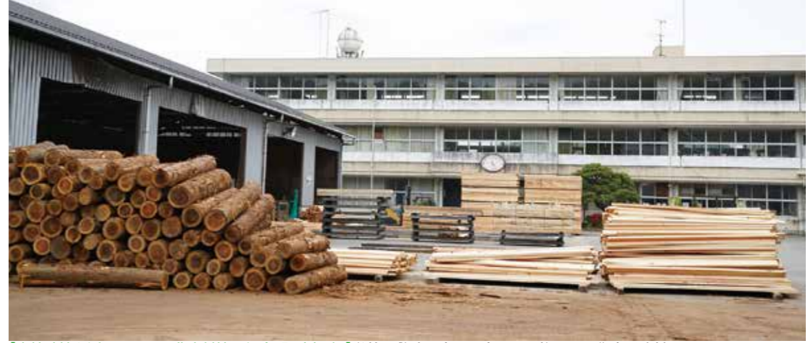
[廃校跡地を活用した、県北木材協同組合那珂川工場]学校の敷地の広さを生かし、柱などの住宅用建材をはじめとした木材を加工する製材工場。木の駅プロジェクトの集材拠点に位置づけられ、住民が運び込む材も受け入れる。プロジェクトにおいて町民から持ち込まれる材の量は、多い月で軽トラック約200台ほど
